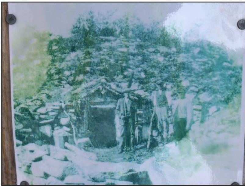
Figur 2 Bilde av den opprinnelige Pederbua
