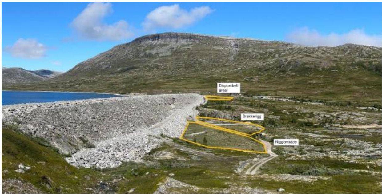
Figur 4-6. Oversiktsbilde over plassering av riggområder.
