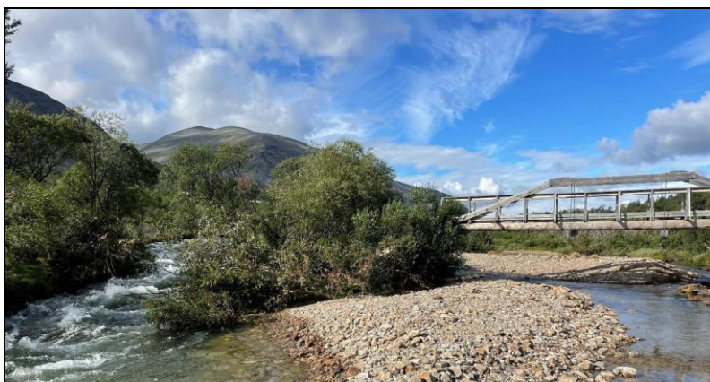
Figur 4 Eksisterende bru med nytt løp
